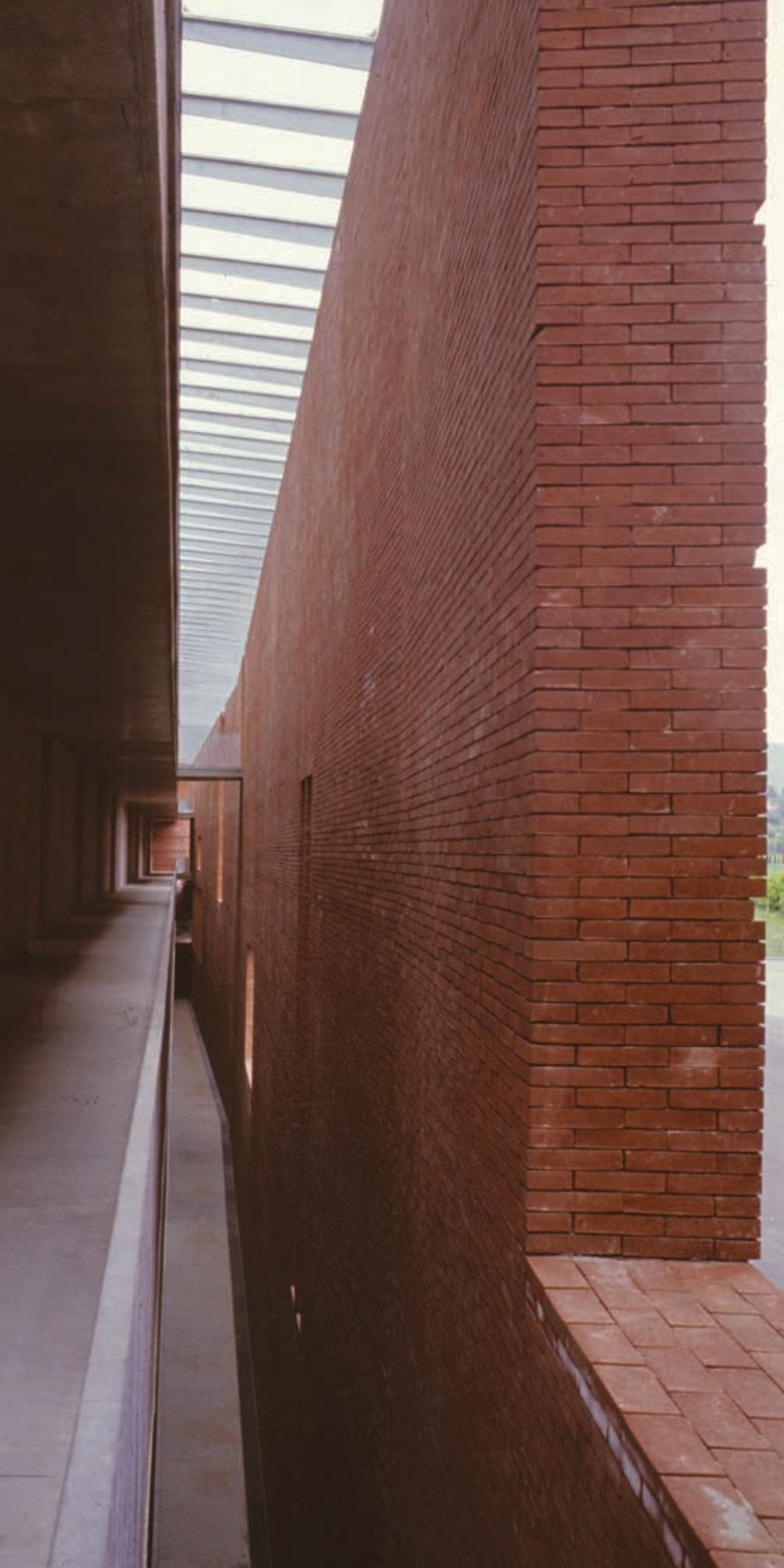
La *terza tendenza* all'uso del laterizio a vista punta ad innovare sostanzialmente l'impiego del materiale attraverso involucri sottili montati a secco, discostati dai supporti strutturali retrostanti e caratterizzati, sotto il profilo formale, da un linguaggio affatto convenzionale.
