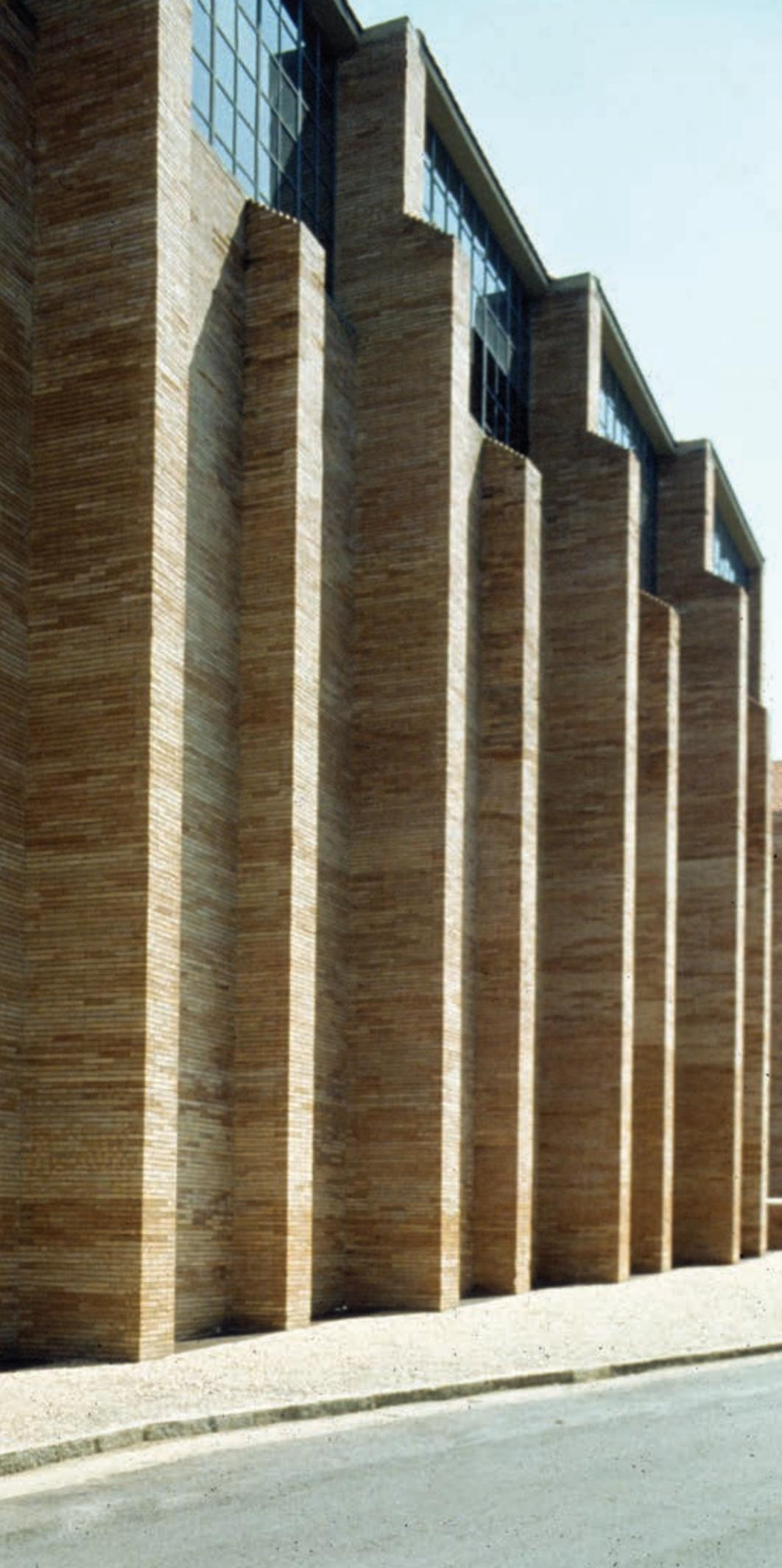
La *seconda tendenza*, maggioritaria sul piano quantitativo, vero serbatoio di accumulo del successo del mattone a vista degli ultimi decenni, è quella che adotta il dispositivo tecnico del “rivestimento a spessore” (nella versione di pareti ad una “testa”), e che insegue la strategia della dissimulazione del muro a mezzo del ricoprimento in laterizio degli strati e delle strutture portanti retrostanti realizzati con altri materiali.
