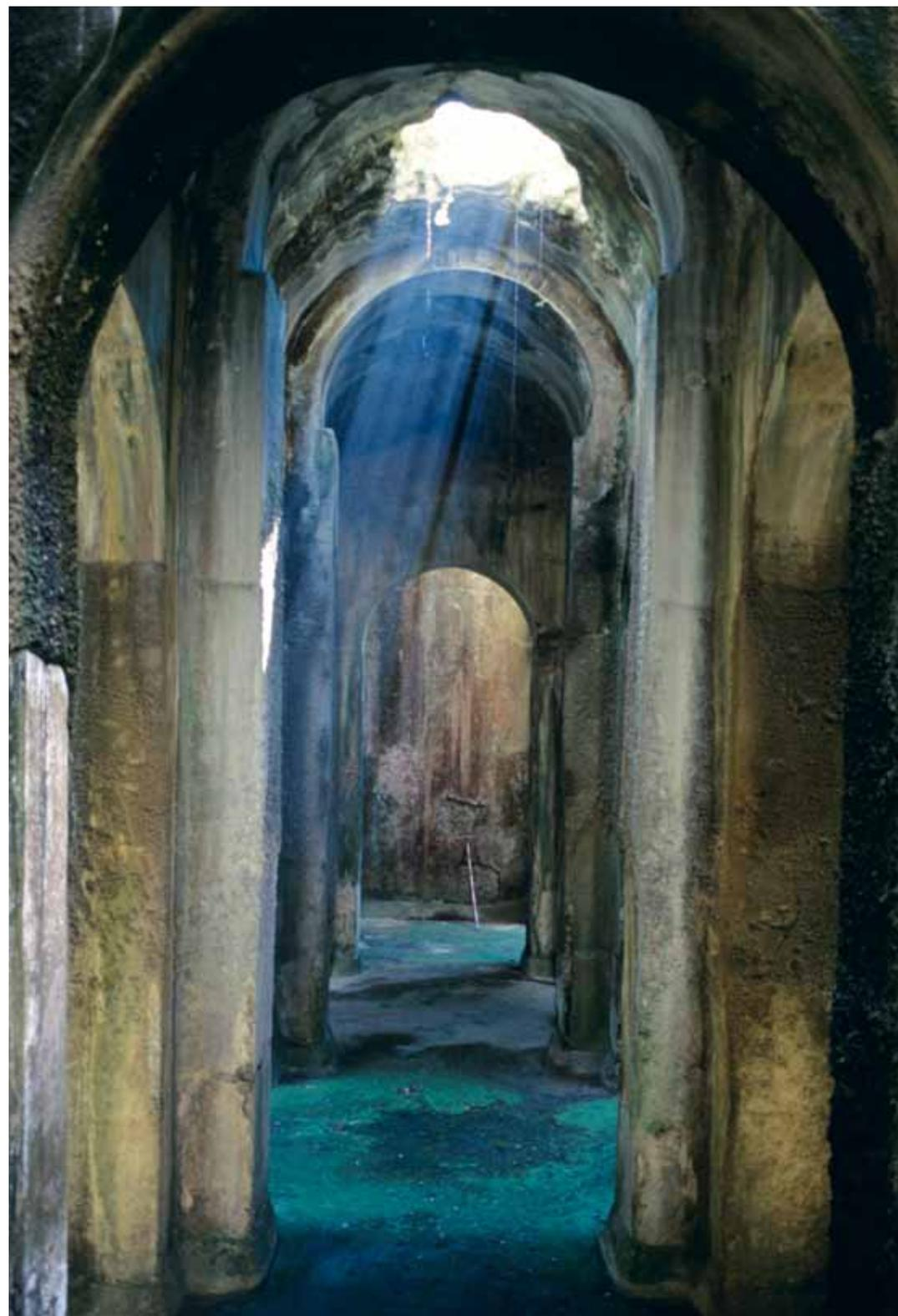
58-59 La Piscina Mirabile a Capo Miseno, (l'attuale Bacoli). L'interno ipogeo con i grandi pilastri cruciformi in tufo rivestiti di cocchiopesto e la planimetria generale della cisterna.
